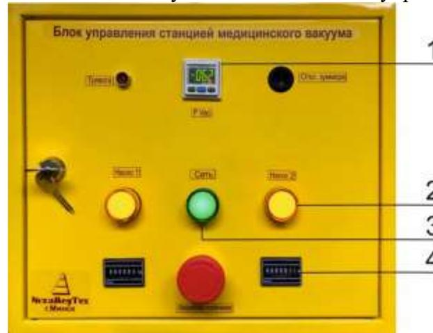
Рис. 4. Блок управления вакуумной станцией.
